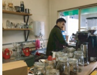
↓事務所を改修。一部は森さん自ら改修し、費用を抑えた。
